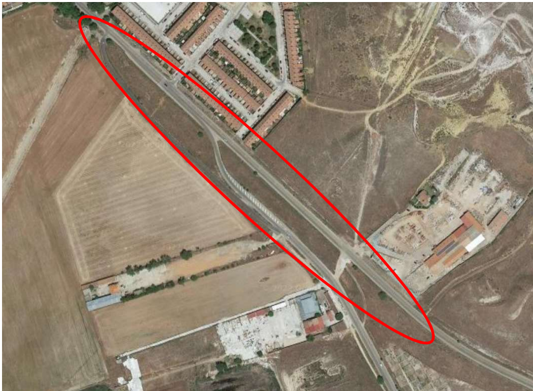
Estado actual de la Cañada a su paso frente al Sector 13
